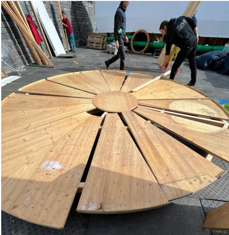
zusammengebaut und durch eine Tür verbunden. Die Unterkonstruktion der Miet-Jurten des Jurtendorfs ist sehr gut auch von Laien aufbaubar, weil die einzelnen Teile mit Symbolen gekennzeichnet sind und man z.B. die komplette Bodenplatte noch drehen kann. Das ist praktisch, wenn es um die Ausrichtung / Platzierung der Tür geht.
